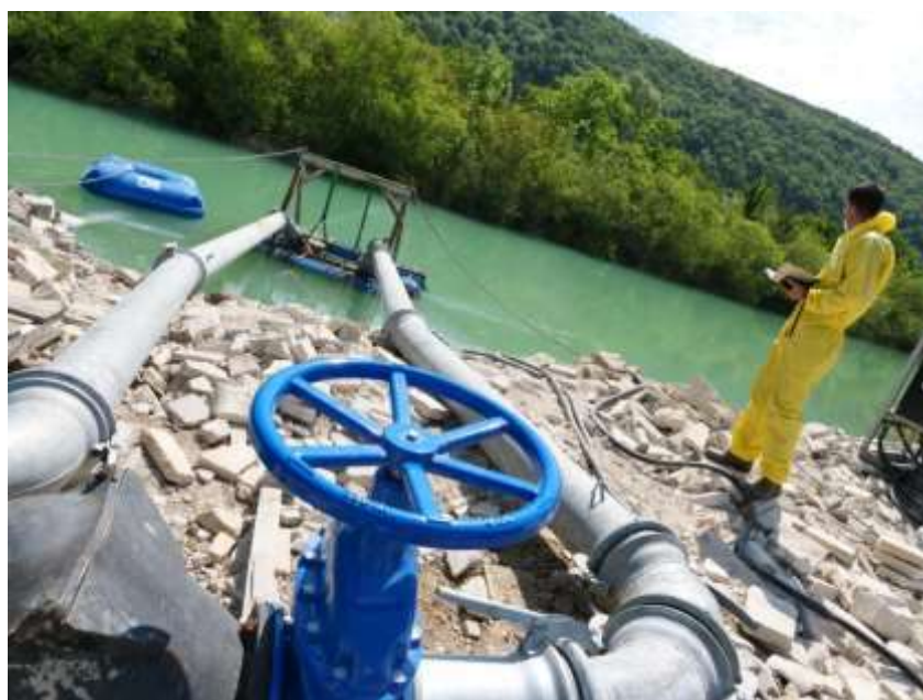
Essais de pompage sur la gravière de Mathay
