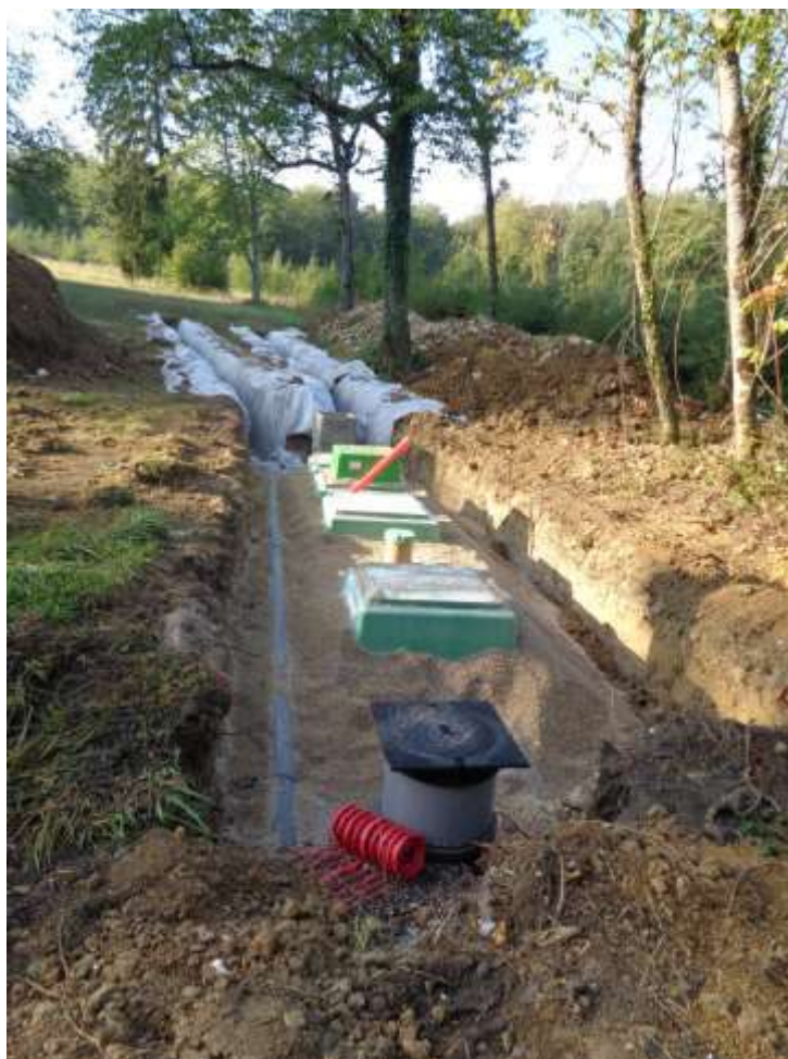
Contrôle d'une installation ANC en construction
