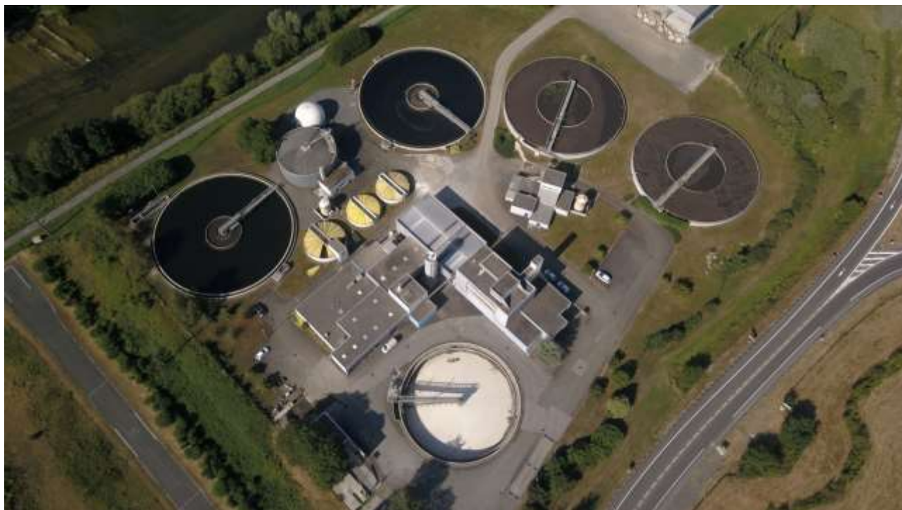
Station d'épuration d'Arbouans
