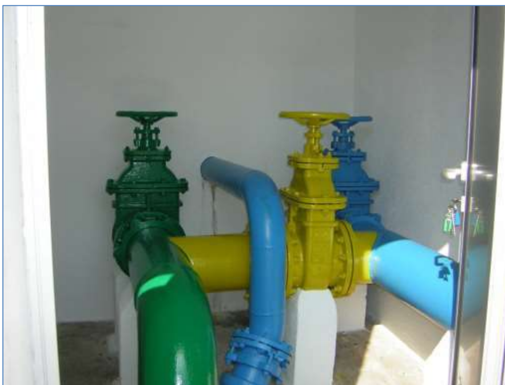
Réservoir Pont de Roide-Vermondans
